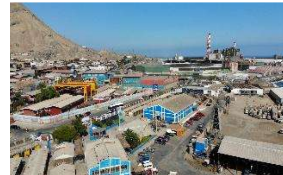
Construcción Puerto de Tocopilla
